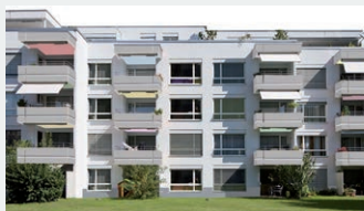
Brunnmattstrasse Zuchwil (SO)
